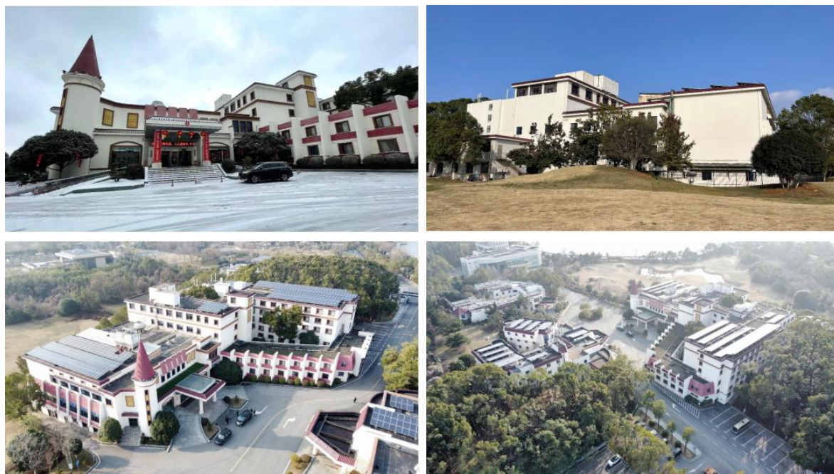
图 4-6 3#楼外立面现状图
