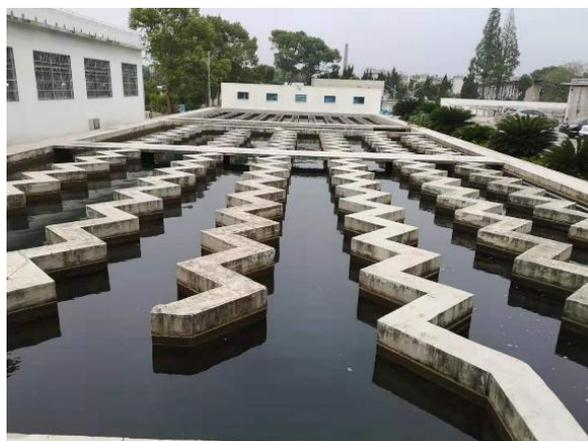
图 3.1-3 4 万 m<sup>3</sup>/d 折板絮凝斜管沉淀池
