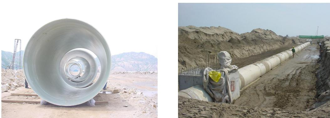
图 4.3.1-4 玻璃钢夹砂管使用实例
