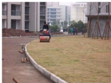
草坪摊铺完的二次碾压
