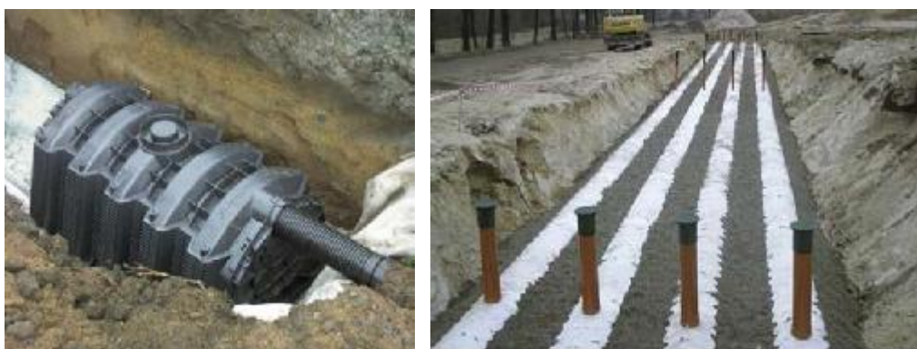
生态渗渠工程
