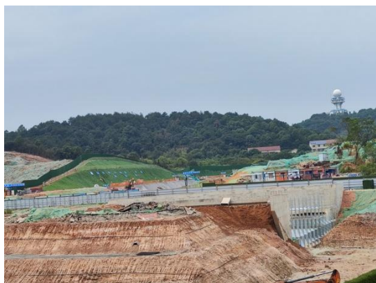
樊陈路施工现场
