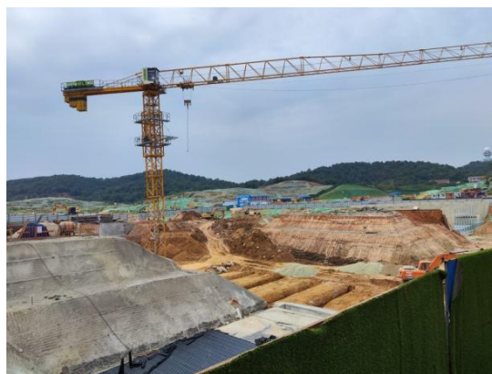
中心医院施工现场
