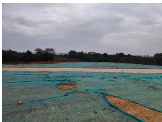
现状岳阳学院施工现场
