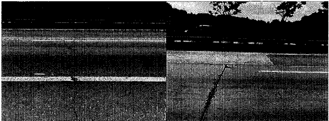
横向裂缝 板角破碎
